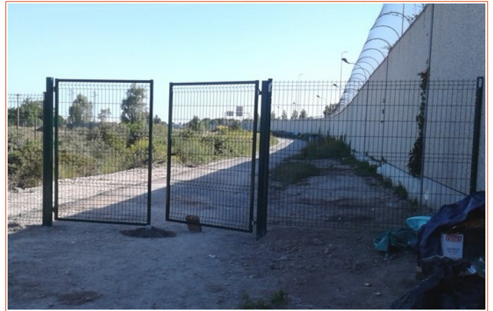
Grillage installé le 23 juin 2020. photo Ferri Matheeuwsen
