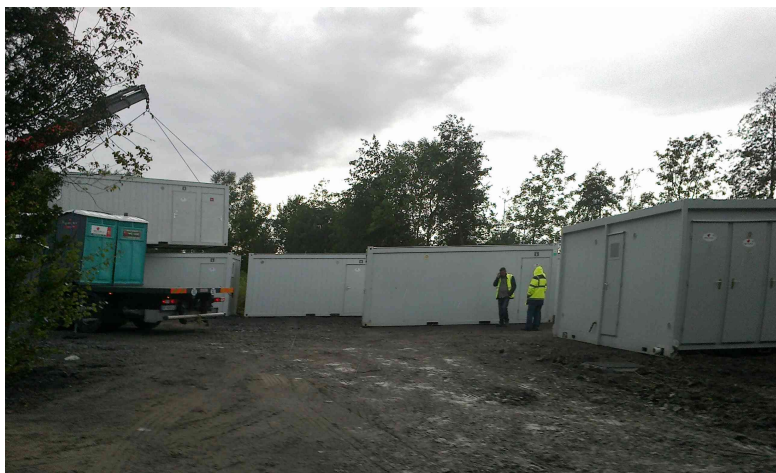
Installation des douches et toilettes. Photo Amélie Fenaux.
